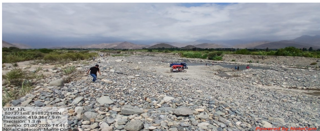
FIGURA N°1 TRAMO DEL CAUCE DEL RIO NEPEÑA COLMATADO, UNA ALTURA APROXIMADAMENTE DE 0.70M.
